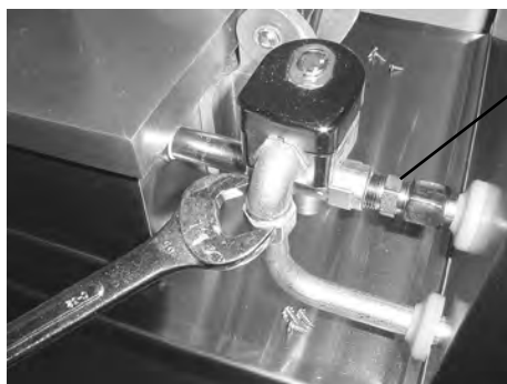
Conduit Fitting Step b
